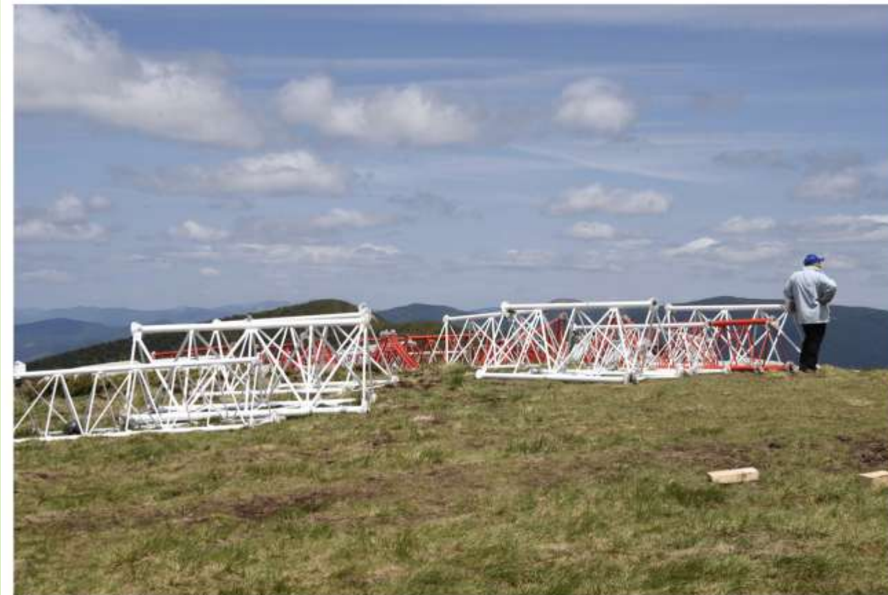
Металеві частини майбутньої щогли для вимірювання вітру. Вершина гори Трояска, висота - понад 1700 м
