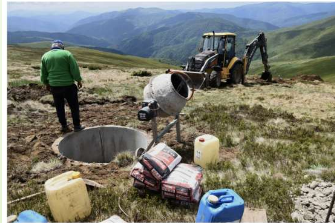
Будівельні роботи зі встановлення щогли для вимірювання вітру на Свидовці, схили гори Трояска
